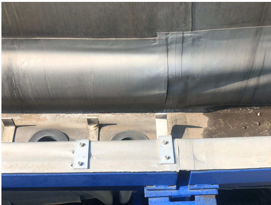
Fotografia 7 – Particolare della gronda con bocchettoni di raccolta acqua
