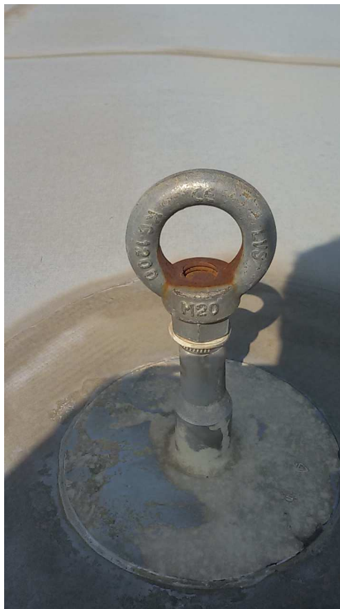
Fotografia 5 – Ganci esistenti su cui effettuare la prova di carico
