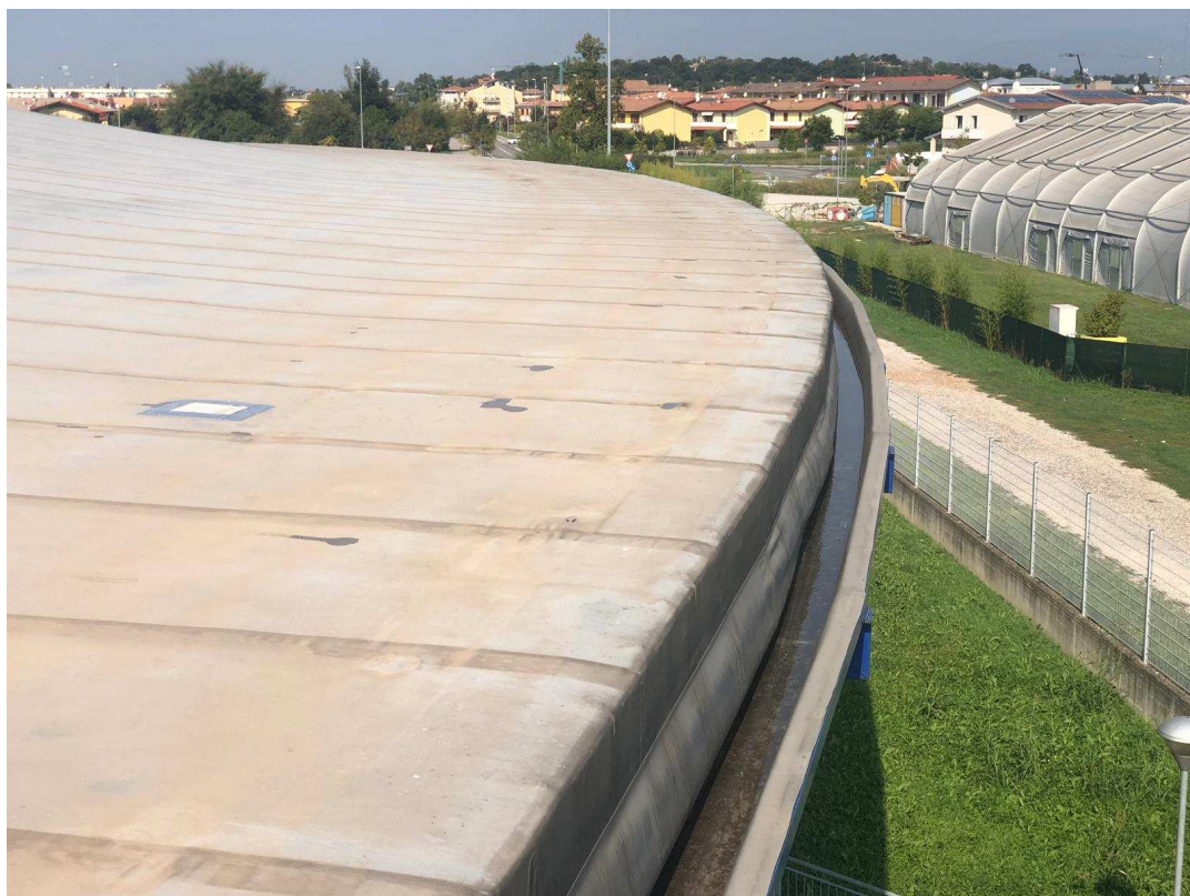
Fotografia 6 – Vista della gronda con PVC esistente rigonfiato
